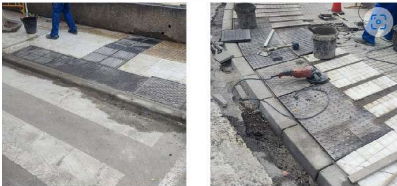
Proyecto en ejecución de la iniciativa 'Rebaje de Acera de José Zarate y Penichet'
