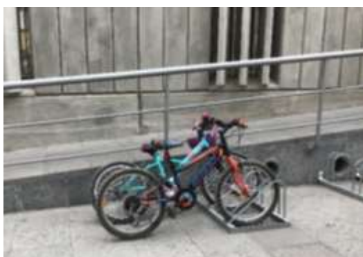
Ejemplo de dispositivo inapropiado para el aparcamiento de bicicletas en zona pública. Casa de la Cultura.
