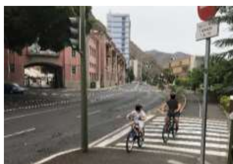
Ejemplo incorrecto de paso de ciclistas inapropiado para el paso de bicicletas por acera bici. Avenida de Anaga, frente al Real Club Náutico de Tenerife.
