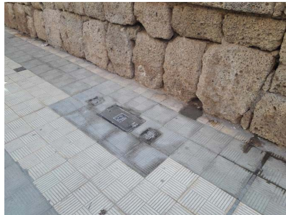
Acometida y arqueta en acera realizada para la fuente de agua:
