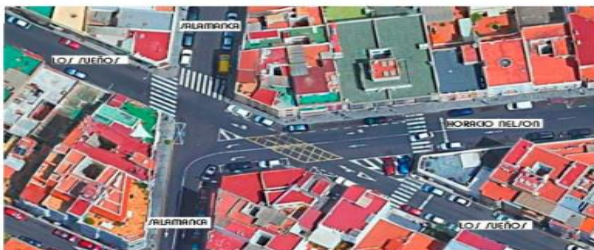
CRUCE PRINCIPAL, PROBLEMA MAL APARCAMIENTO Y DIFICULTAD VISIBILIDAD TRÁFICO EN ESQUINAS, DIFICULTAD PASO PEATONES
