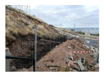
obras de construcción del nuevo muro de contención, de hormigón y 30 metros de largo, finalizarán en este mes de julio en el plazo de tres semanas.
